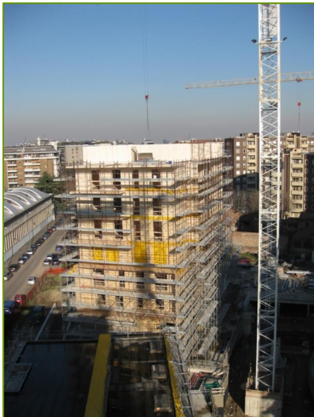
solette - elementi orizzontali - con pannelli di 2,50 m in modo da assicurare la regolarità e rigidezza della struttura
